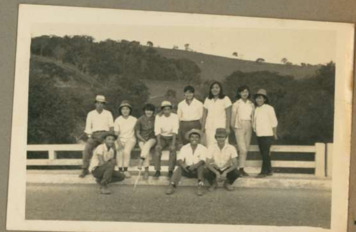
PONTE SOBRE O RIO SAPUCAI
